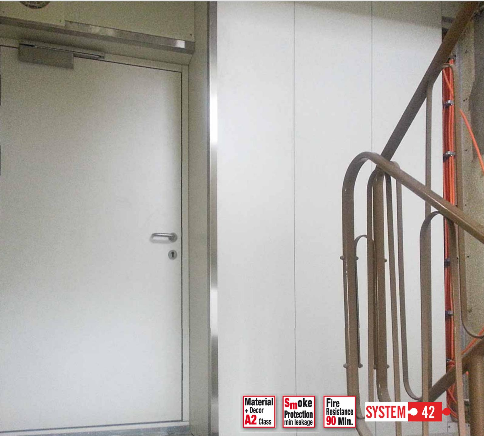
Ansicht vom Treppenhaus: PRIOWALL Wandsystem mit Feuerschutzabschluss PRIODOOR FSA, mittig der Abströmschacht für RDA-Anlagen mit PRIOWALL Elementen verkleidet und rechts ein Kabelschacht
