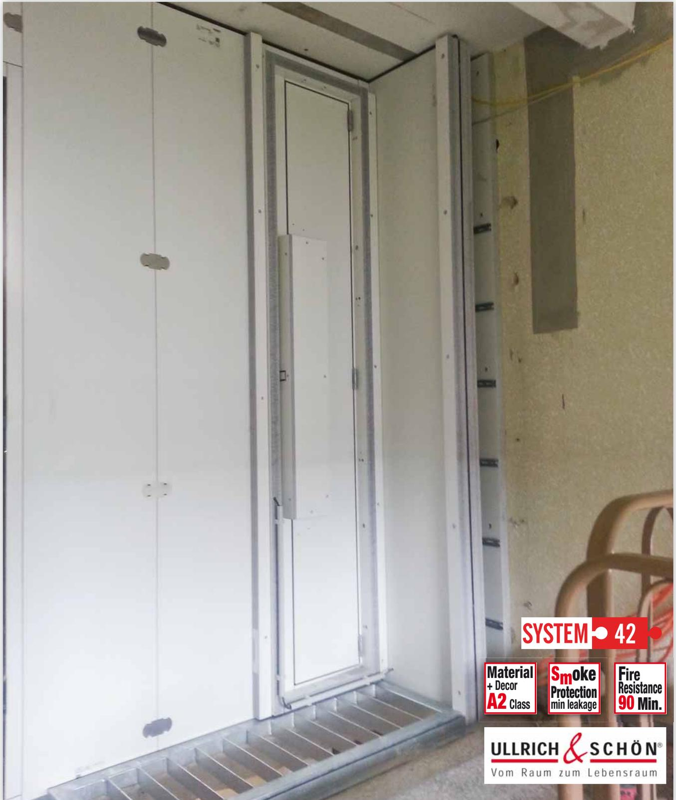
Bauphase: Rückansicht PRIOWALL Wandsystem mit Entrauchungsklappe PRIODOOR ETX RDA und dem neuen Abströmschacht vor der Verkleidung mit PRIOWALL Elementen
