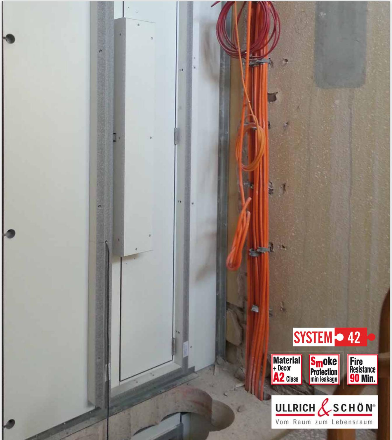
Bauphase: Rückansicht PRIOWALL Wandsystem mit Entrauchungsklappe PRIODOOR ETX RDA und dem neuen Abströmschacht vor der Verkleidung mit PRIOWALL Elementen
