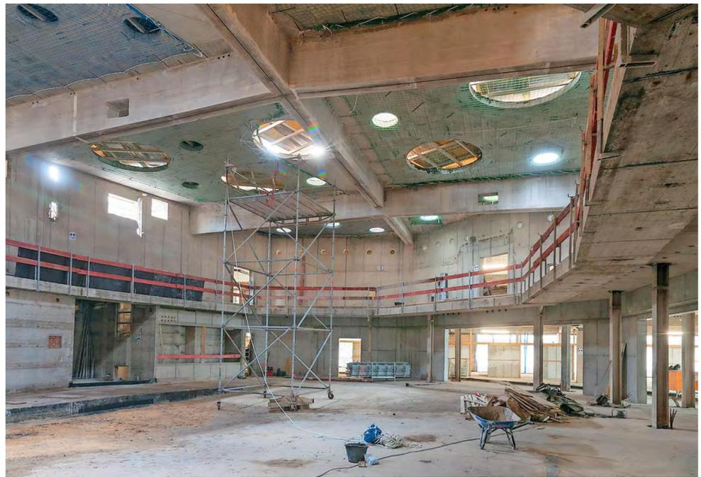
Die Dachkonstruktion des Plenarsaals wurde komplett erneuert, gedämmt und mit kreisrunden Öffnungen versehen. FOTO: TÜMMERS
