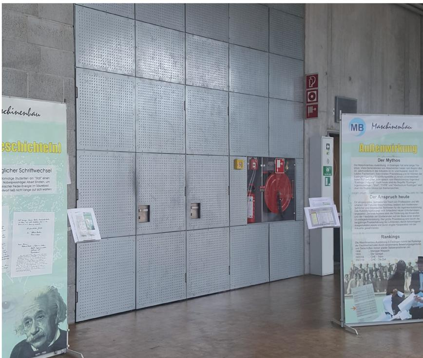
Vor der Sanierung: Einfache Metalltüren und -platten ohne Feuerwiderstand sichern die Verteilung
