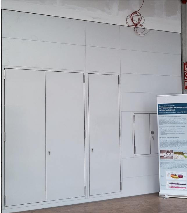
Feuerwiderstandsfähige Einhausung – Vor der Montage der Metallplatten – mit Anbindung an eine hergestellte Trockenbauabschottung mit statischem Stahlhohlprofil
