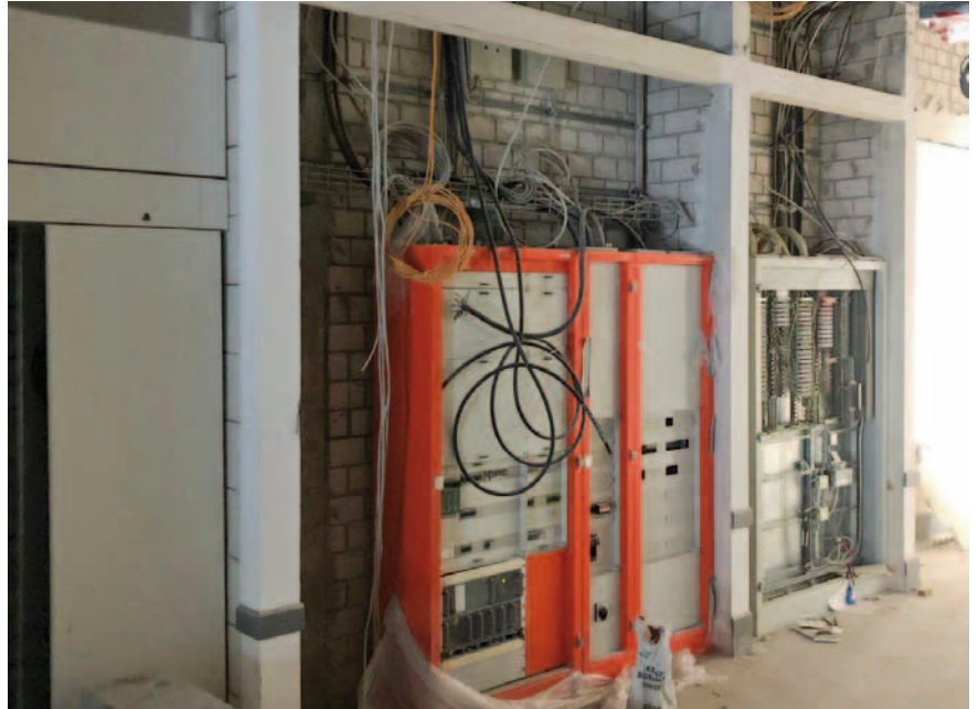
Während der Sanierung – Demontage der bestehenden Verkleidung - Brandlasten der bestehenden Elektroinstallationen
