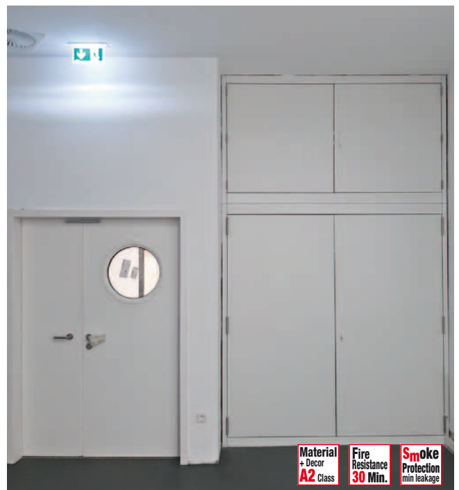
Die obenliegenden Revisionsabschlüsse ermöglichen eine komfortable Zugänglichkeit der Installationen z.B. für eine Nachbelegung.
