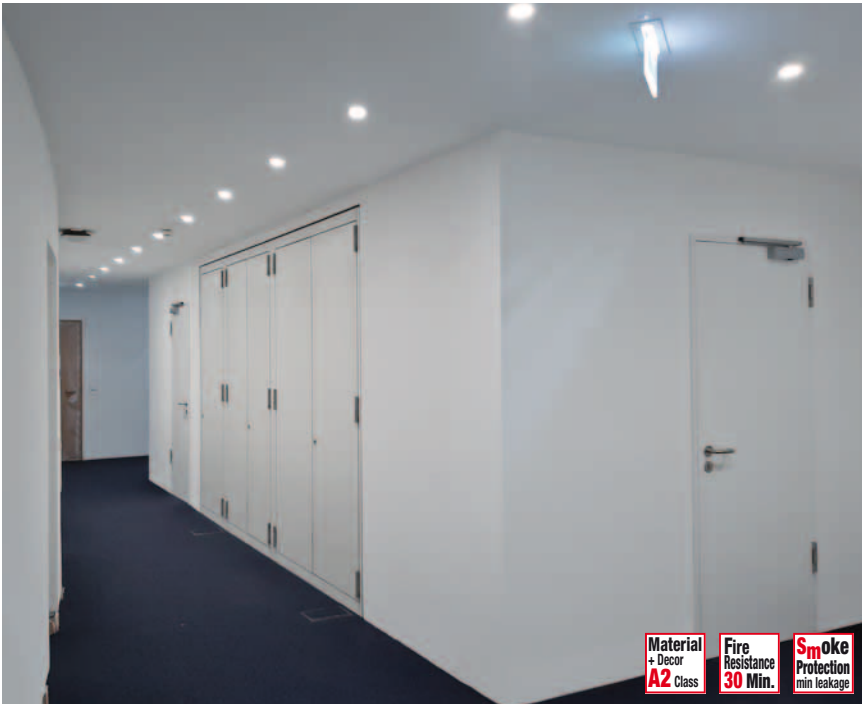
Feuerwiderstandsfähige Verkleidung bestehender Elektroinstallationen und Verteiler
