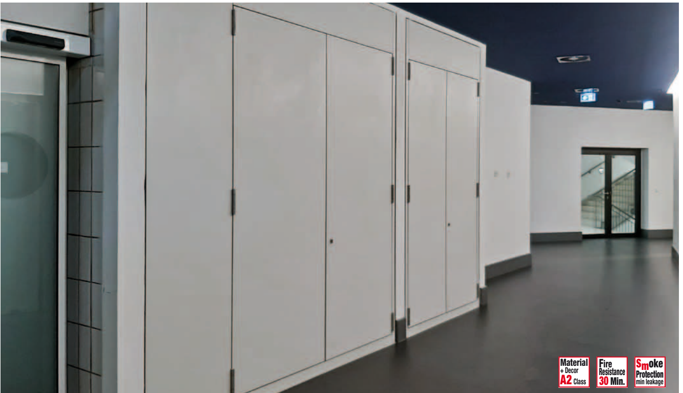
Nach der Sanierung – Feuerwiderstandsfähige Abtrennung der Brandlasten gegenüber dem notwendigen Flur. Schnelle saubere Montage durch vorgefertigte Elemente.
