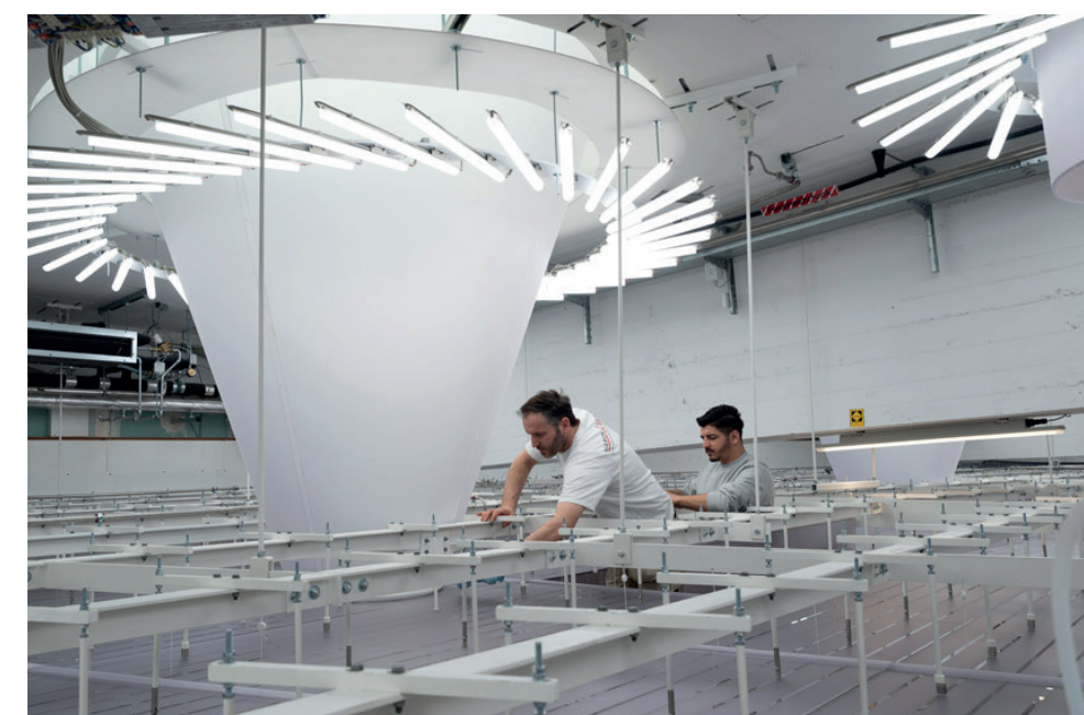
Arbeiten an der Deckenkonstruktion des Plenarsaals
