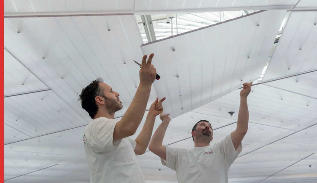
Einsetzen der Deckenelemente im Plenarsaal des Stuttgarter Landtag
